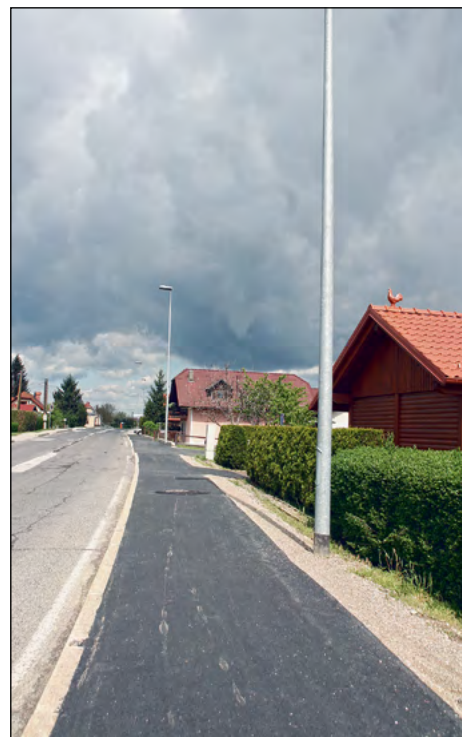
Urejen, na novo asfaltiran po zaključku del je tudi pločnik v Skorbi.
