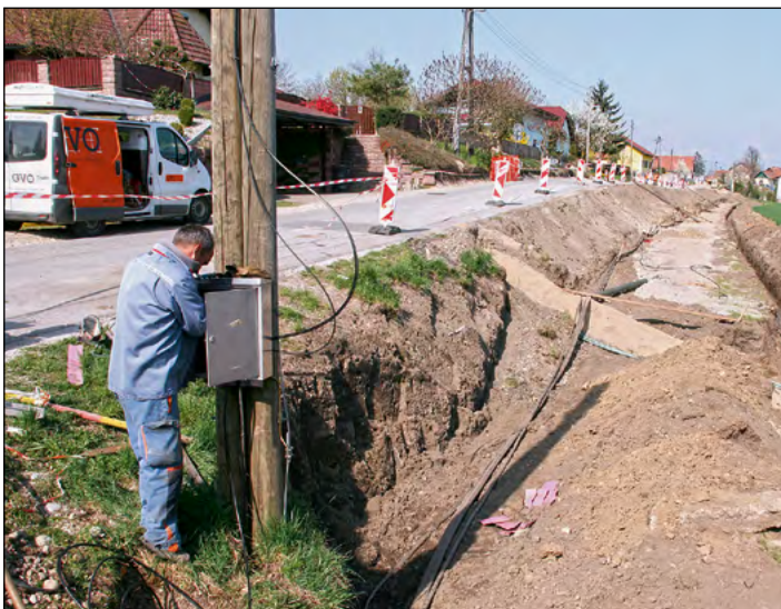
Na lokaciji Zgornja Hajdina so v zaključni fazi obsežna zemeljska dela.
