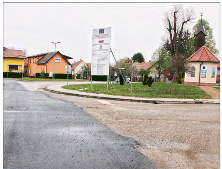
V naselju Draženci, kjer so konec minulega leta izgradili še eno vejo kanalizacije, je že urejena nova asfaltna prevleka.
